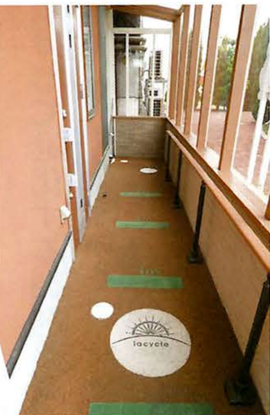
建物の北側のガーデンルーム内は検査測定室。上州特有の強風対策も兼ねている
