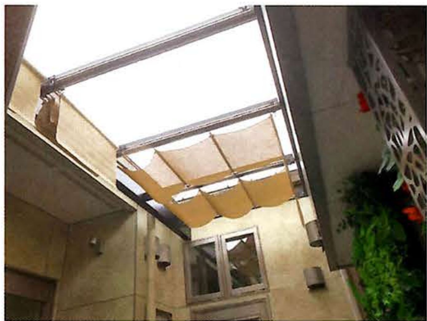
中庭の天井にはシェード(※現在は鳥が入って来るため改良中)
