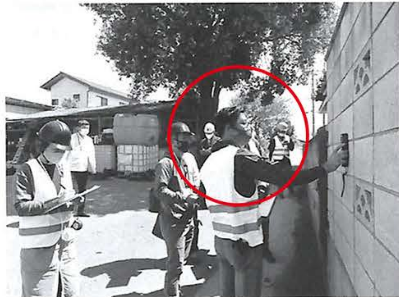
鉄筋探査機でブロック塀の配筋状況を確認
